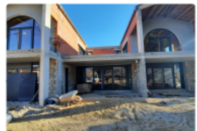
Travaux du Pôle Multiservices
