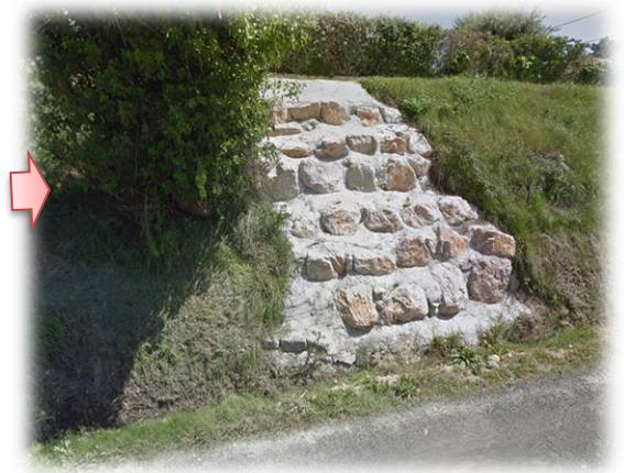
Les travaux réalisés au printemps permettront d'éviter un nouvel effondrement du talus. Une bordure a été installée afin de canaliser les eaux de pluie.
